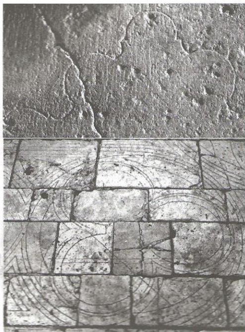
Epures tracées sur un mur de l'église de Noirlac et sur le sol de la cathédrale de Bourges (Cher).
