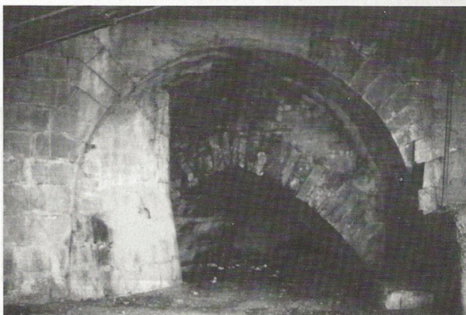
La première arche du pont s'appuie sur les fondements de la porte de la ville et reçoit les tabliers du pont-levis
