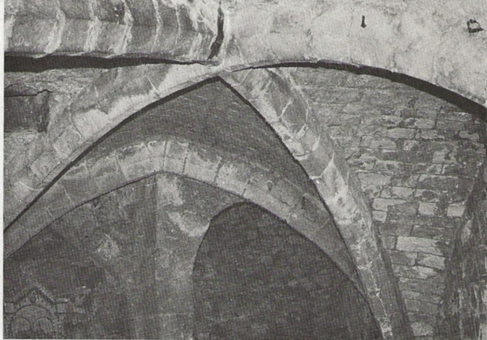
L'examen attentif du mode de construction des voûtes des caves nous renseignera sur les techniques employées et permettra de les dater
