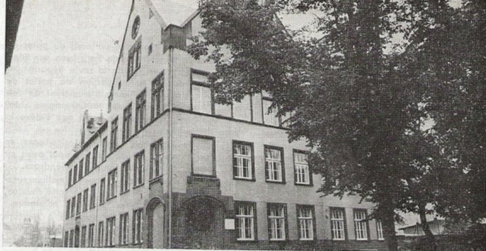
Le vieux Lycée de Mayen de la St.Veitstrasse
